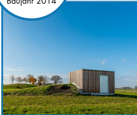
Brunnen 4 Tiefbrunnen Tiefe ca. 104 m Leistung: 20 L/s Baujahr 2014
