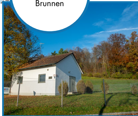
Maschinenhaus Steuerung der Brunnen
